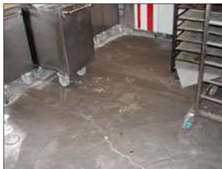
Afb. 2 De stofafgifte wordt duidelijk zichtbaar dankzij schoenafdrukken op het oppervlak.
